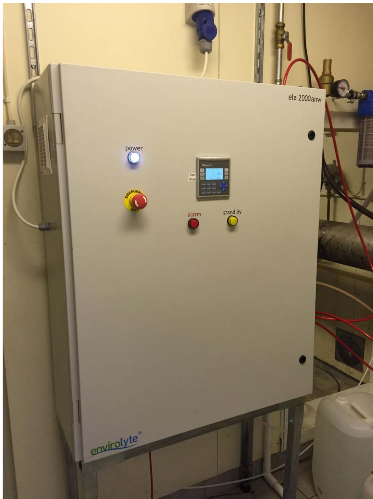
EnvirolYTE ELA-2000ANW analyte generator
